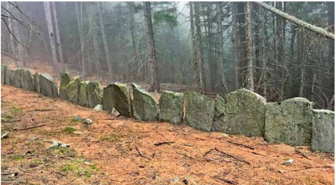
Le lastre in sasso posizionate verticalmente delimitano i pascoli dell'Alpe Mornera.
