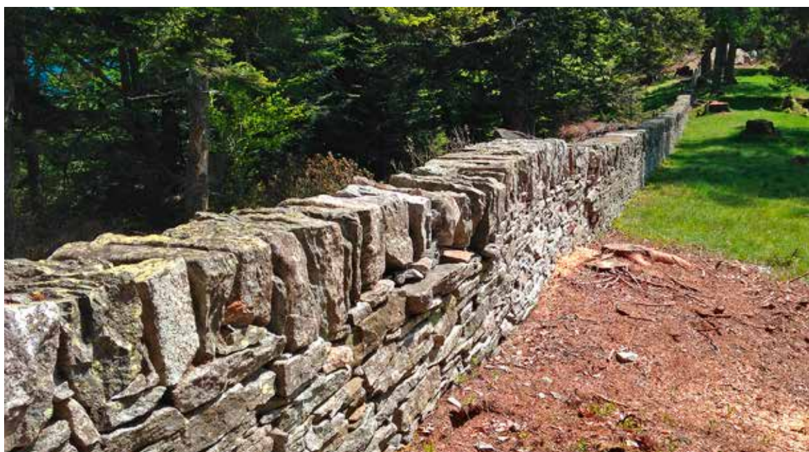
1000 mètres de mur de délimitation avec des pierres de couronnement placées verticalement. / 1000 Meter lange Grenzmauer mit senkrecht aufgestellten Decksteinen.
