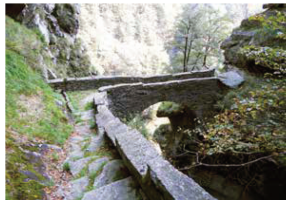
Ponte lungo la via storica che da Osogna conduce all'Alpe Scign Brücke auf dem historischen Verkehrsweg Osogna-Alpe Scign Pont sur la voie de communication historique Osogna-Alpe Scign
