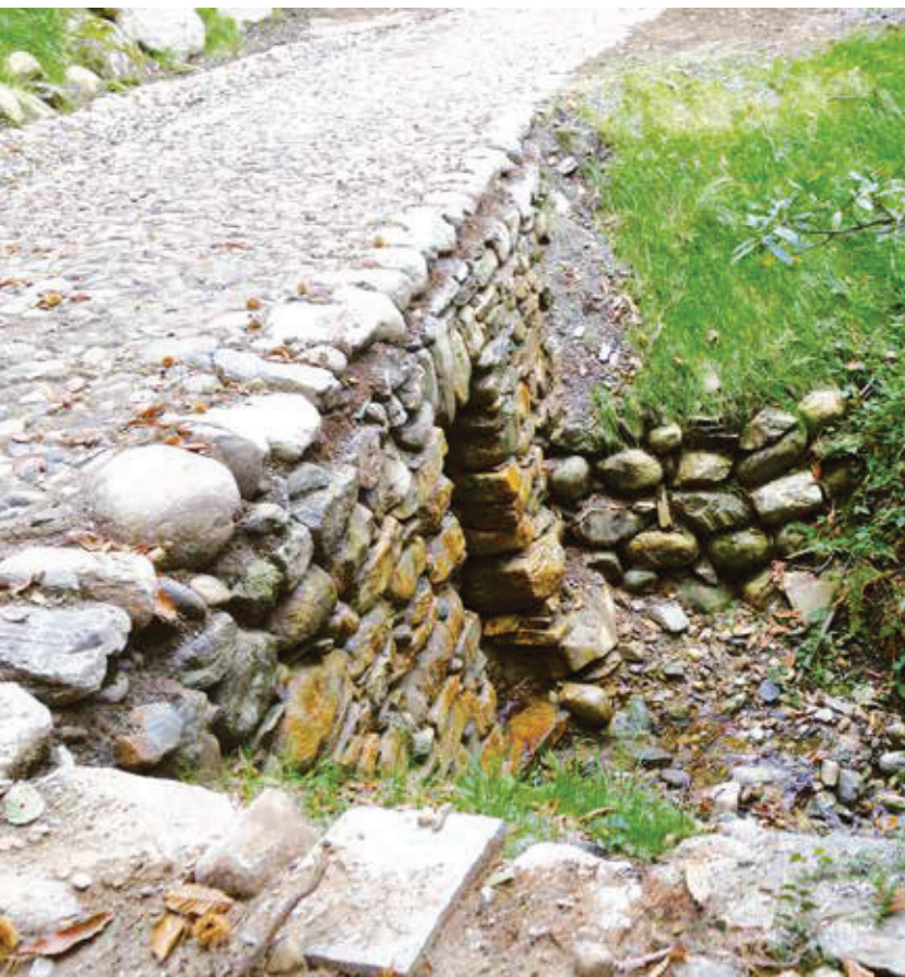
Nuovo muro di sostegno con passaggio
