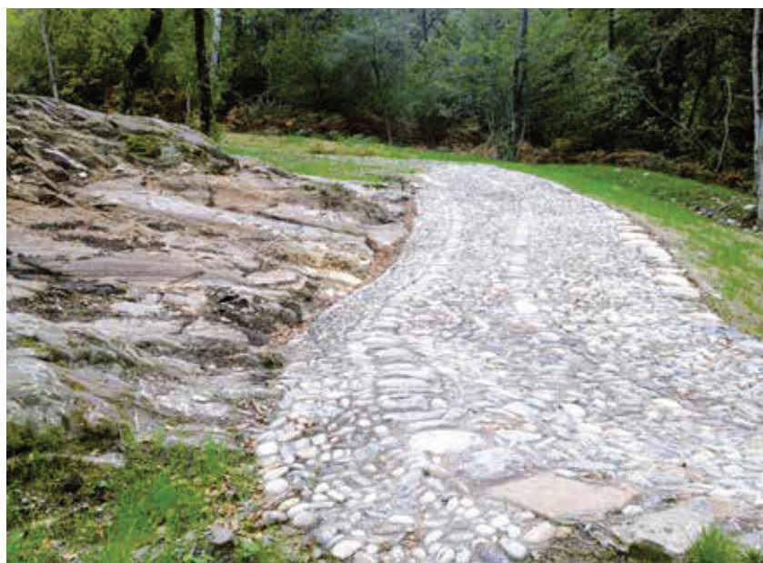
... e dopo, con il nuovo selciato ... puis avec le nouveau pavage ... und nachher, mit neuer Pflasterung
