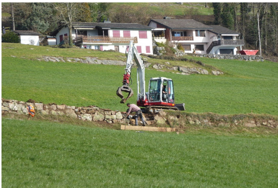
Sanierung der oberen Grenzmauer im Gebiet Tuschmatt. Hier arbeitet der Grundeigentümer mit. Holztafeln schützen das unterliegende Gelände von wegrollenden Steinen.
