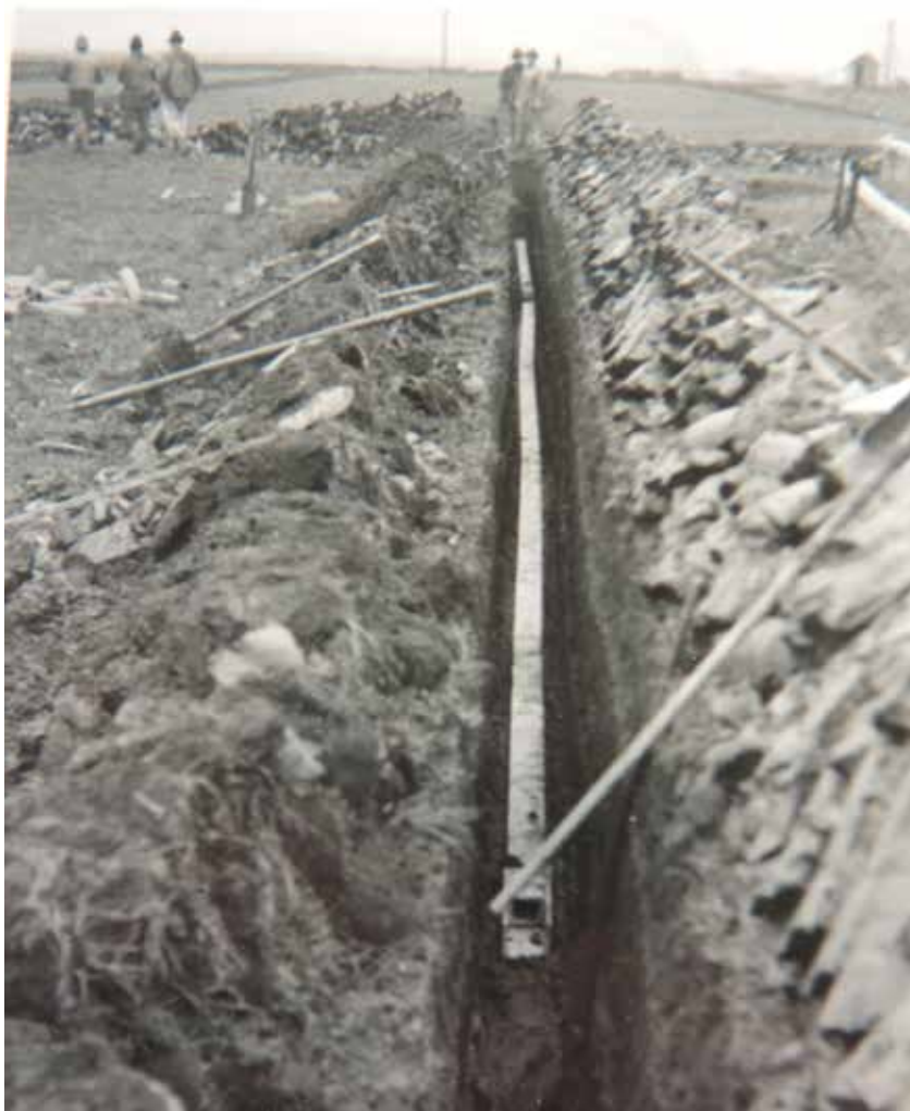
Mit dem Bau von Drainagen wurde das Land entwässert und die Fläche landwirtschaftlich nutzbar gemacht.
