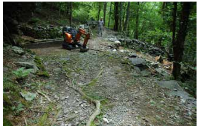
La fontana Da Fid – durante e dopo il ripristino.
