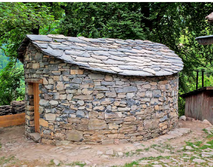
Instandstellung einer Nevèra (Schneekeller) auf der Alpe Loasa, Bruzella (TI)
