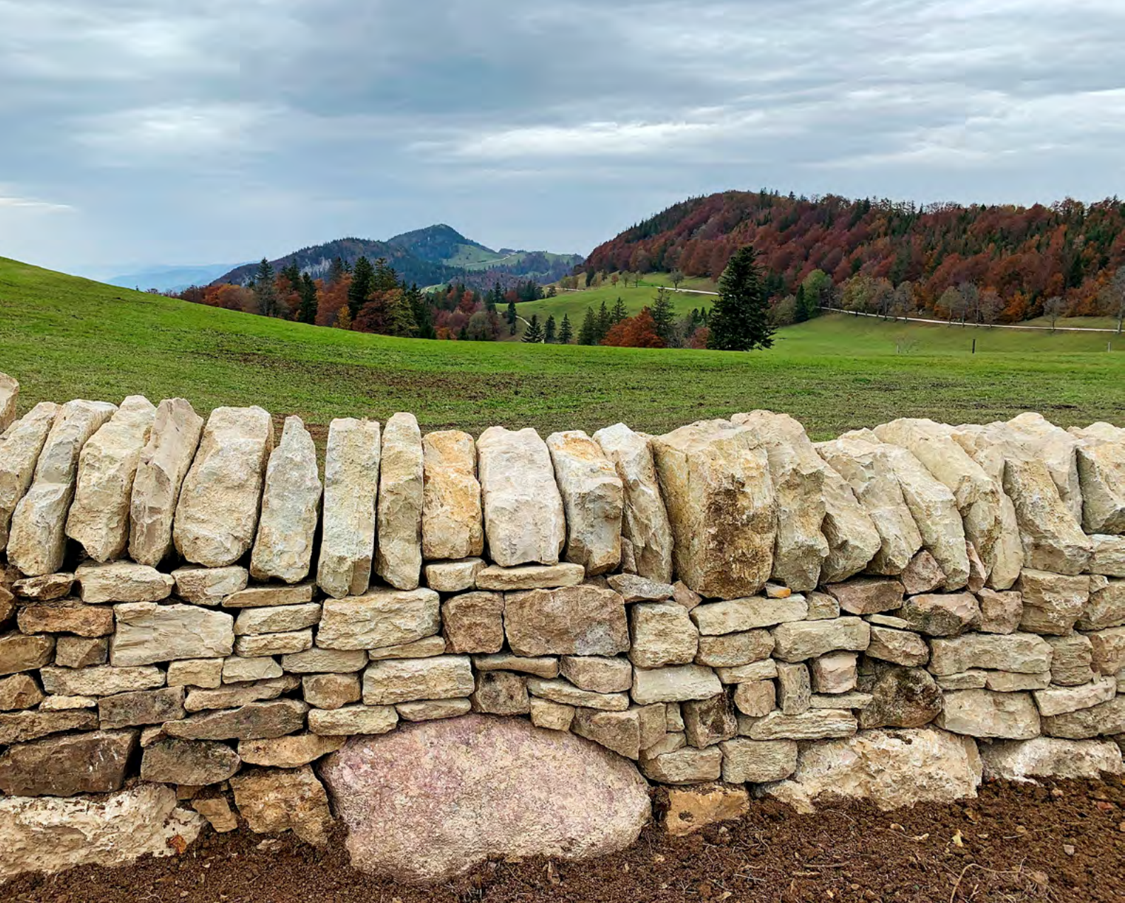
Die Sanierung der Trockenmauer auf dem Weissenstein (SO) wurde mit Freiwilligen durchgeführt. (Foto: Caroline Beglinger Föderova)
