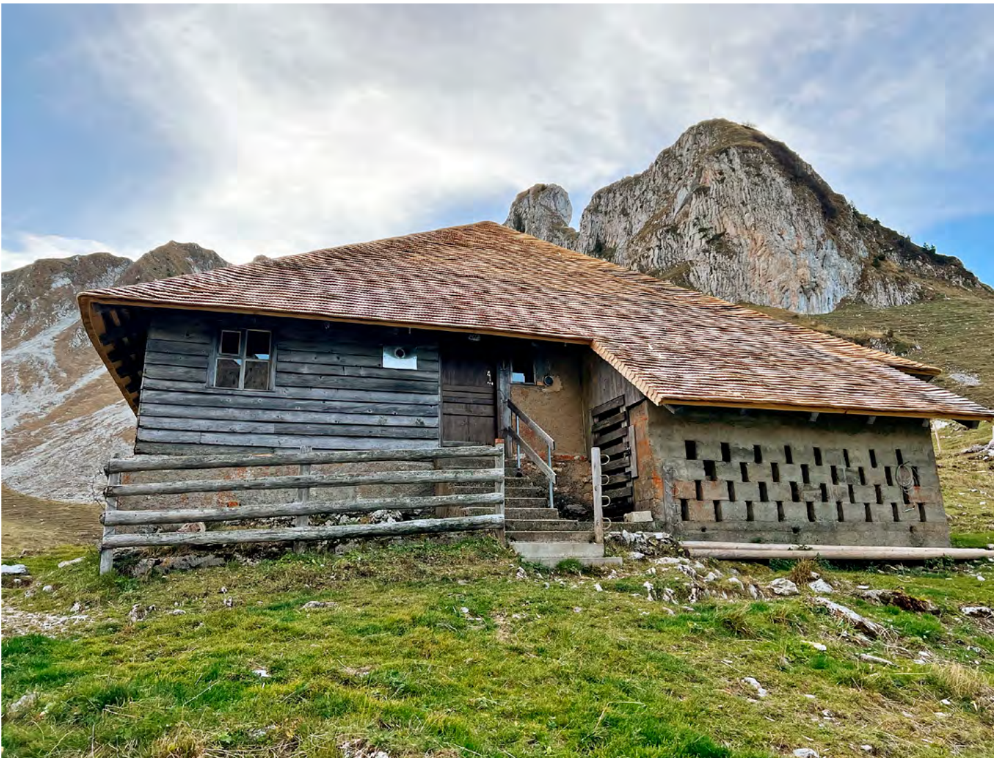
Sanierung des Schindeldachs der Chummlihütte in Rüscheegg (BE)
