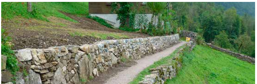
Sanierung von Trockenmauern durch Zivildienstleistende, Ennenda GL
