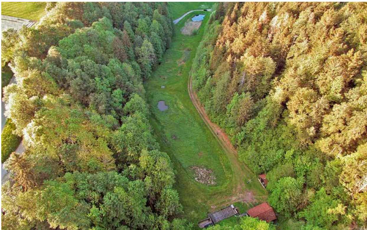
L'ancienne STEP naturelle, avant travaux: bonne intégration paysagère
