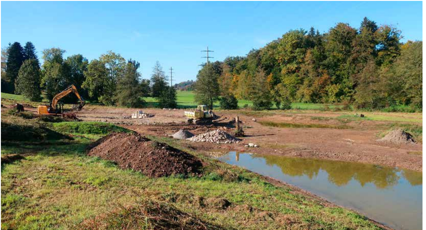
Bauarbeiten für ein vielfältiges Lebensraummosaik bei Herzogenbuchsee BE
