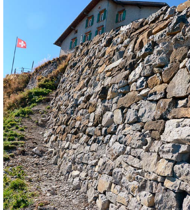
Erneuerte Trockenmauer auf 1924 m über Meer: Stützmauer für den Wanderweg zum Berggasthaus Schäfli im Alpstein AI
