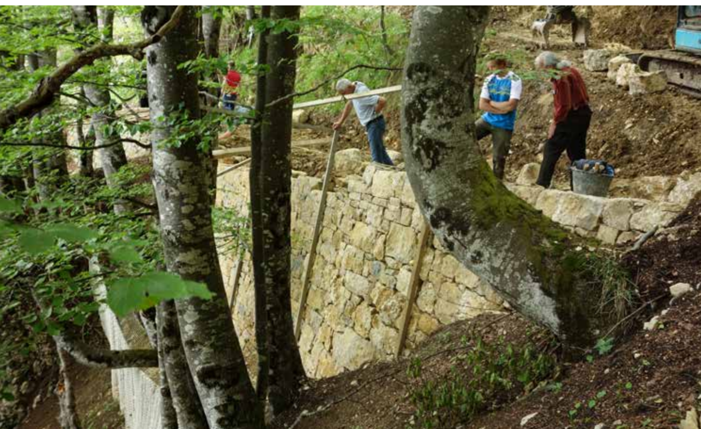
Réfection des murs de pierre sèche de la charrière de Raimeux, Grandval BE
