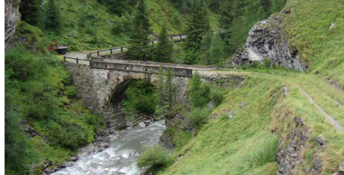
Sanierung Alte Averserstrasse, Andeer GR
