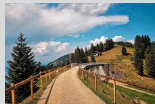
Sanierung Brücke Unterstetten Rigi-Bahn, Gersau SZ
