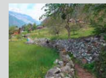
Sanierung Trockenmauern im Gebiet Buechholz-Ledi, Silenen UR
