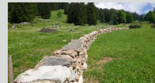
Instandstellung Trockenmauern Brunnenberg, Luchsingen GL
