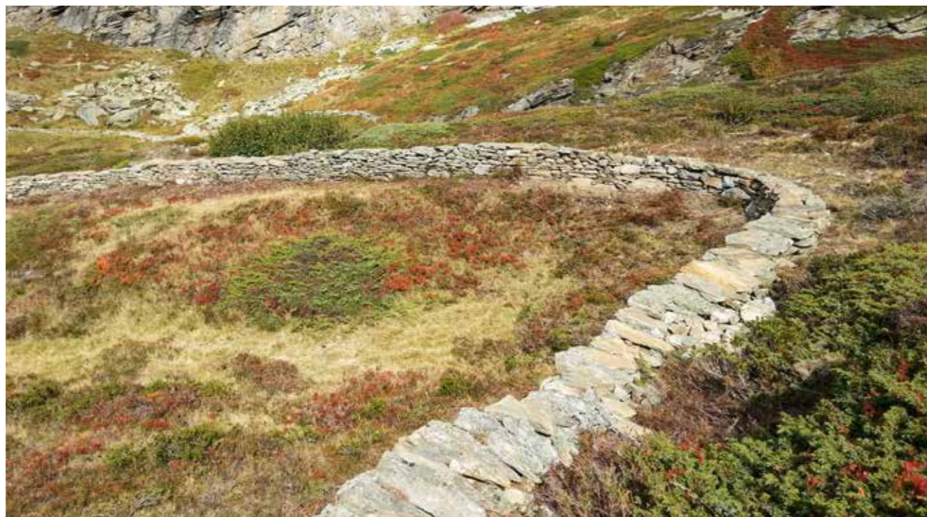
Sanierung Trockenmauern Bergalpe Simplon, VS
