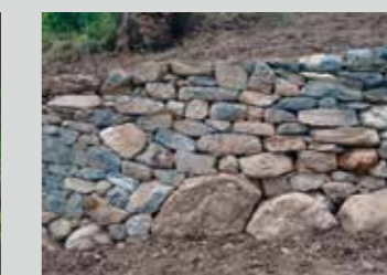
Sanierung Trockenmauern Engelberg OW
