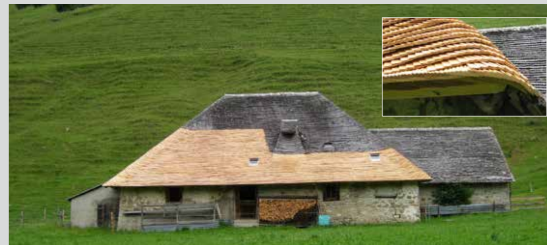
Réfection en tavillons de la toiture d'un chalet d'alpage, Val-de-Charmey, Cerniat, La Gotta 97, FR
