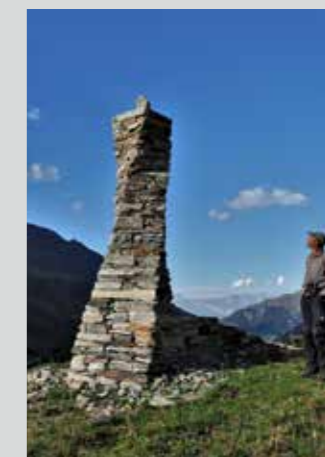
Wiederinstandstellung Trockenmauer Matt, Vals GR
