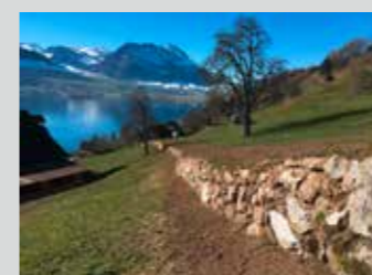
Sanierung Trockenmauern, Ennetbürgen NW
