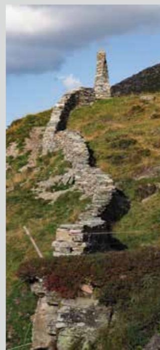
Wiederinstandstellung Trockenmauer Matt, Vals GR
