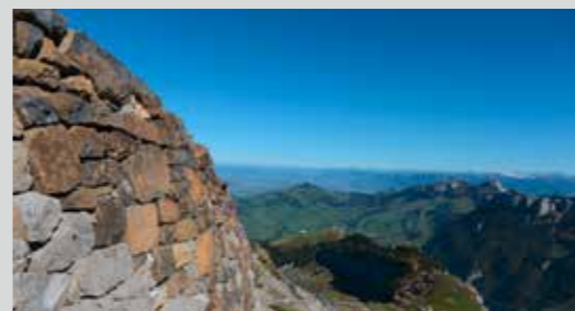
Sanierung Trockenmauer Schäfler, Schwende AI
