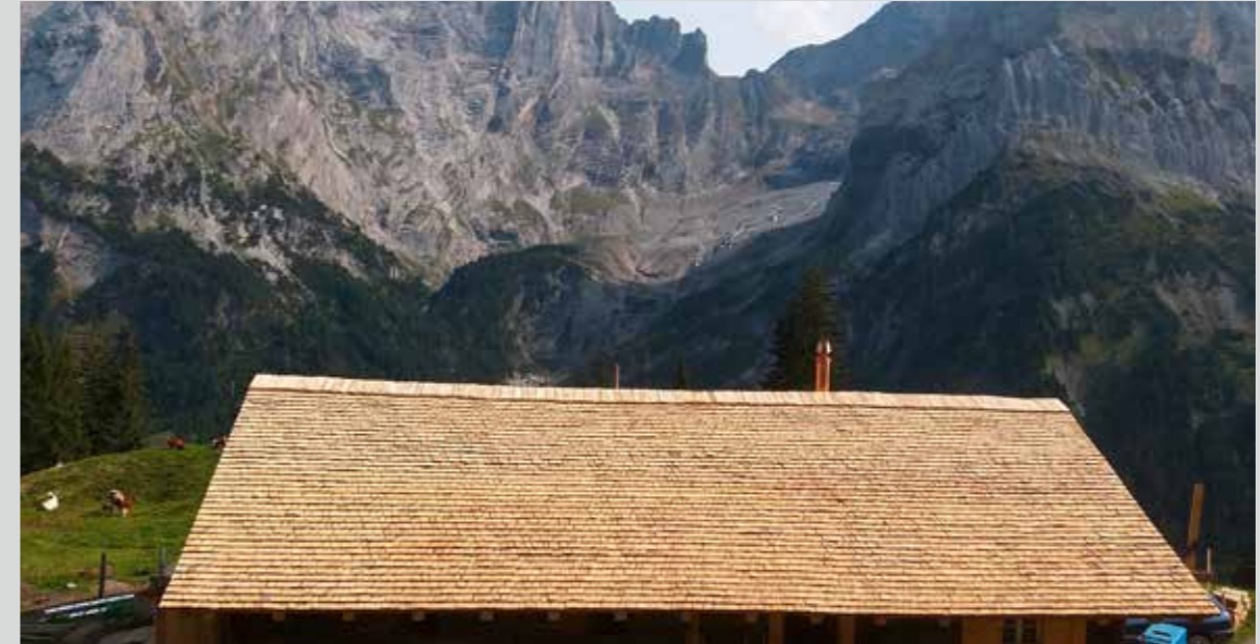
Restaurierung der Alp-/Sennhütte Mettlen, Meiringen BE
