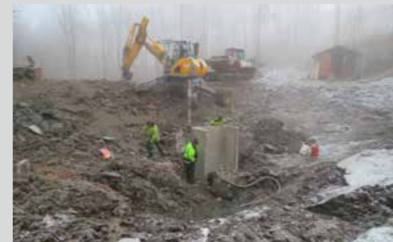
Sanierung des Weihers «Obere Wis», Holderbank SO, vorher
