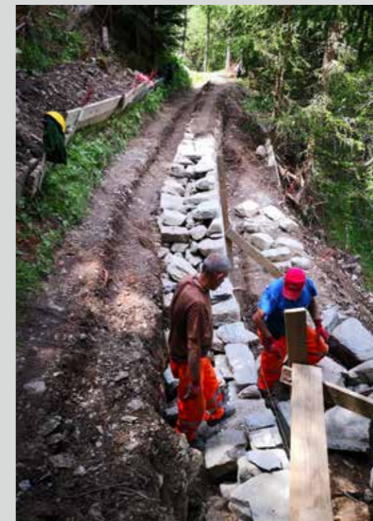
Sanierung Alte Suon, Bürchen VS
