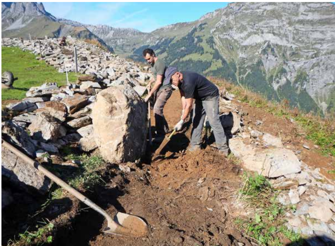
Die Restaurationsarbeiten sind anstrengend und aufwändig.
