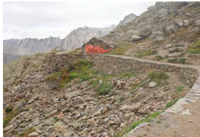
Signes de travaux en cours dans un paysage sauvage
