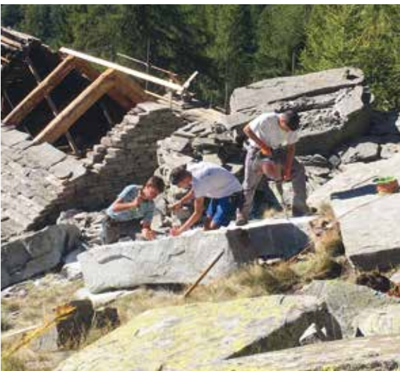
Giovani operai al lavoro per ristrutturare le cascate di Corte Grande
