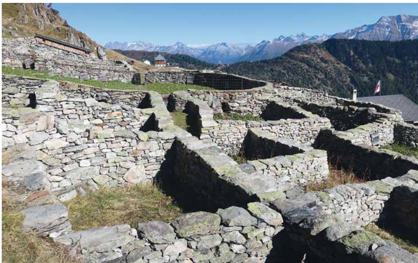
Vorzeigeprojekt auf der Belalp: die erneuerten Trockenmauern der «Färricha»
