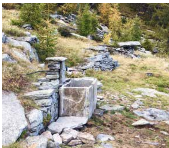
Una delle due fontane posate durante l'estate che ora garantiscono l'approvvigionamento d'acqua a Corte del Lago e Corte Grande
