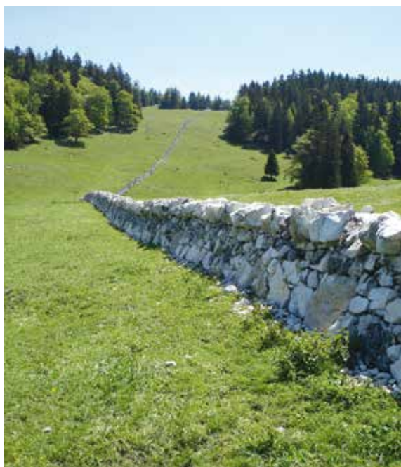
Grâce au soutien du FSP, le Parc Jura vaudois a pu restaurer plus de douze kilomètres de murs en pierres sèches entre 2010 et 2017.
