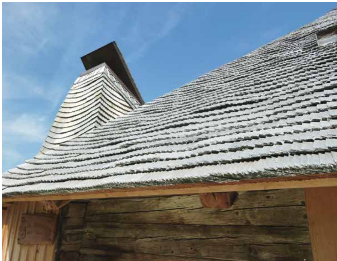
Travail artisanal impressionnant: toiture et borne en tavillons à La Monse.
