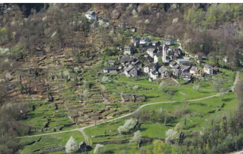
...e dopo la conclusione dei lavori di recupero del paesaggio agricolo.
