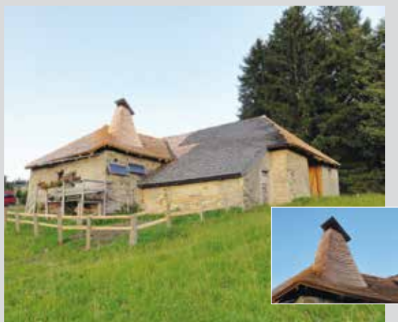
Réfection en tavillon de la toiture du chalet d'alpage Sur Plané, Semsales FR
