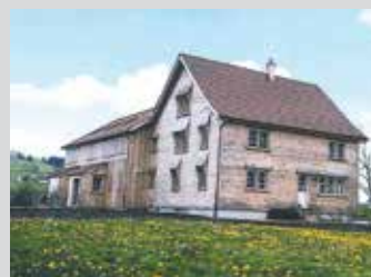
Erneuerter Schindelschirm, Schönbüel AI
