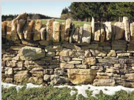
Réfection d'un mur de pierres sèches, Pouillerel, La-Chaux-de-Fonds NE
