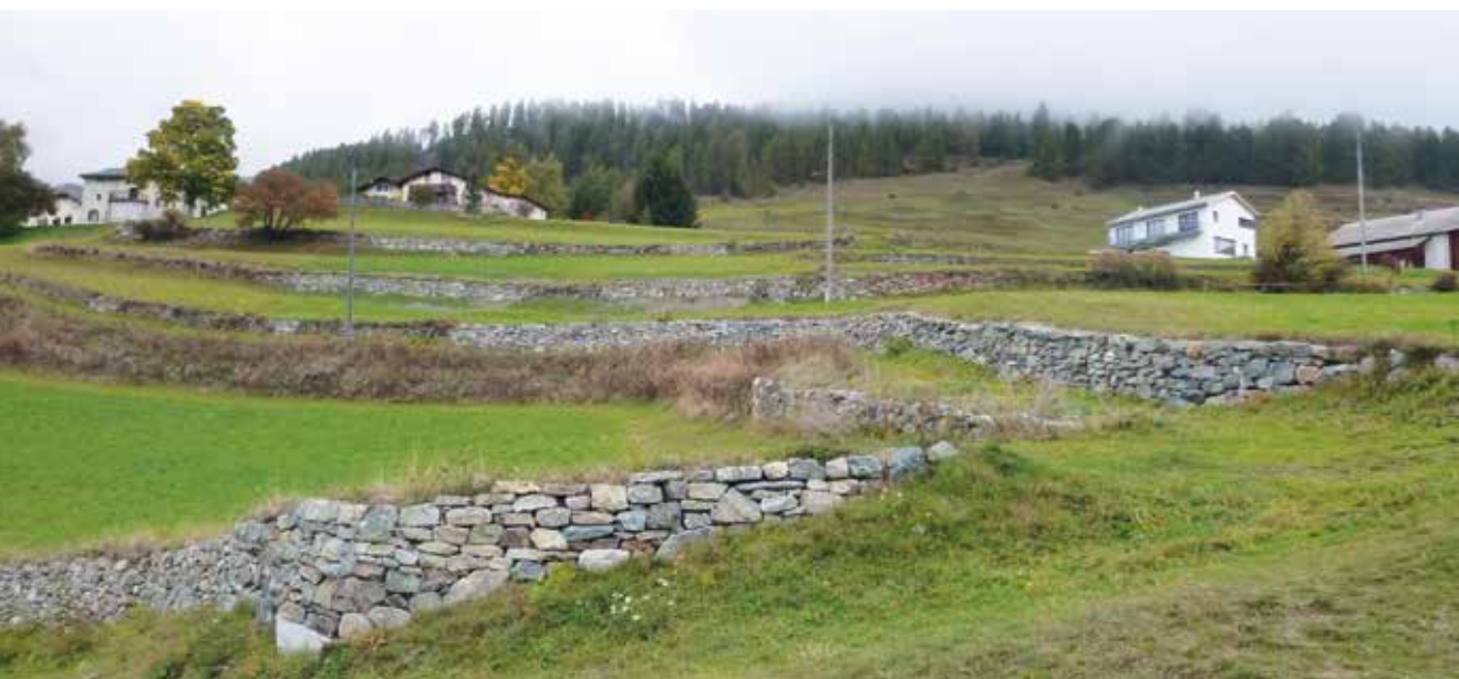
Wiederaufgebaute Trockenmauern im Unterengadin GR
