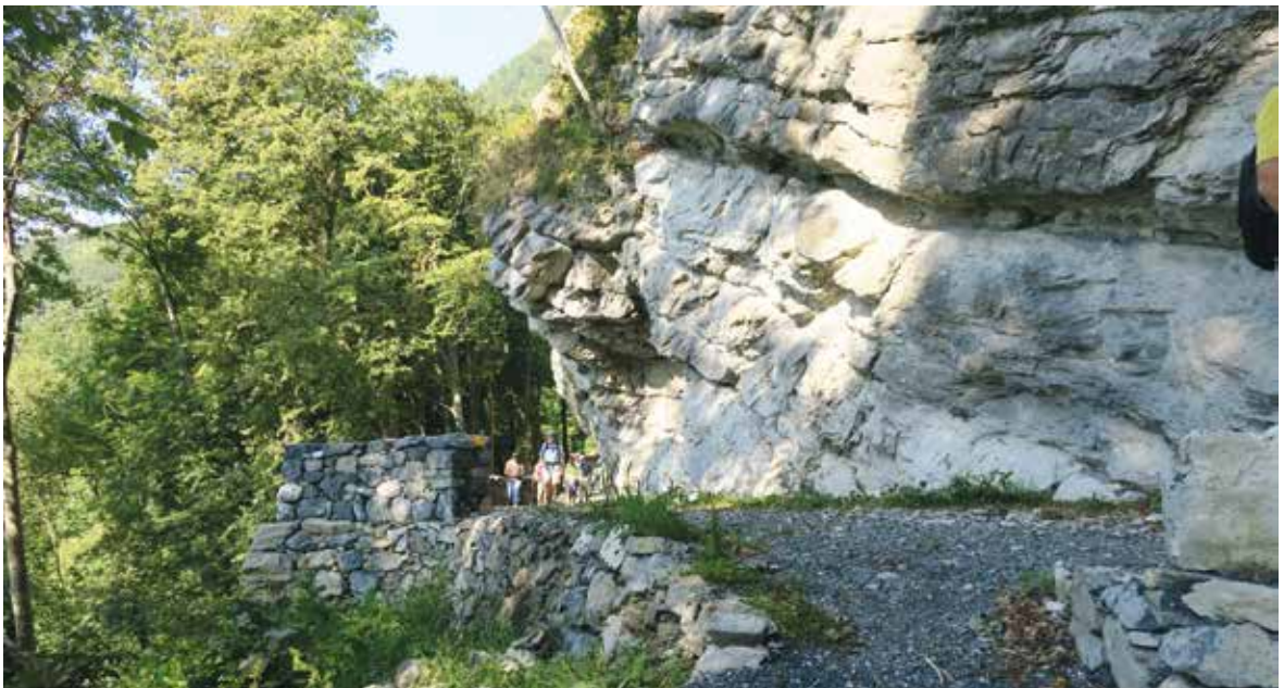
Sanierte Trockenmauern an der Alten Schollbergstrasse zwischen Sargans und Wartau SG
