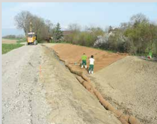
Remise à ciel ouvert d'un tronçon du Chamboton, Jussy GE: pendant et...
