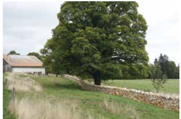
Le Parc Naturel Régional Chasseral a organisé la reconstruction de ce mur de pierres le long du Chemin des Pionniers (Montagne de Cernier, Val-de-Ruz).
