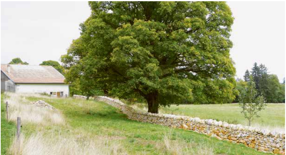
Un mur de pierre sèche restauré le long du Chemin des Pionniers
