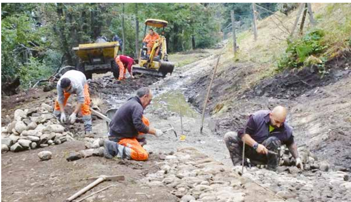
Lavoratori durante gli interventi
