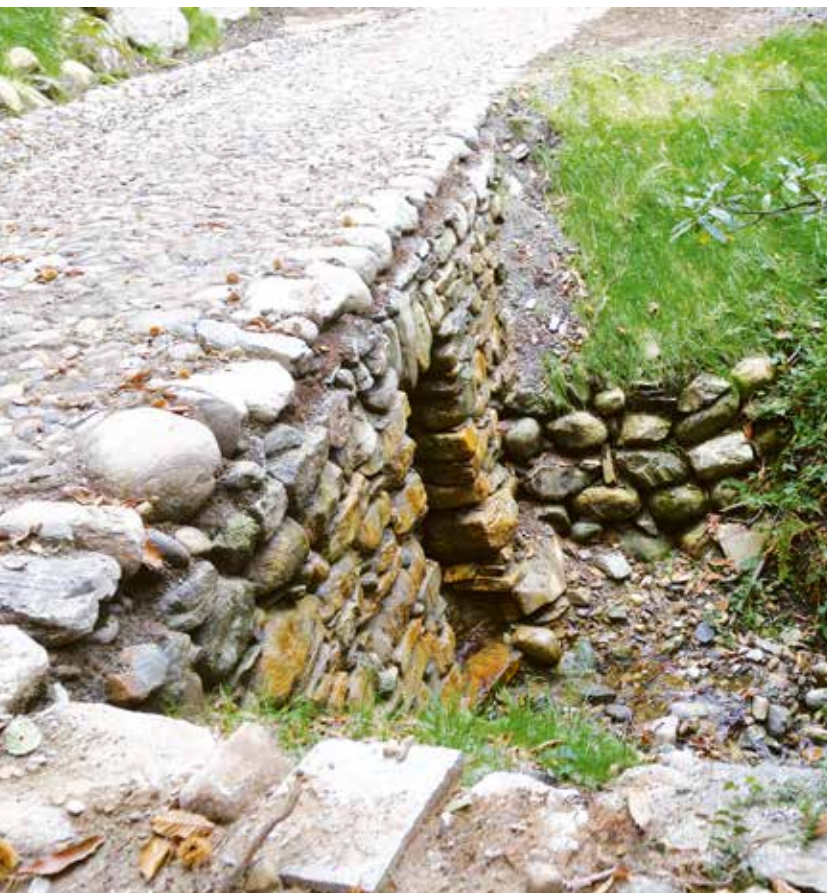
Nuovo muro di sostegno con passaggio
