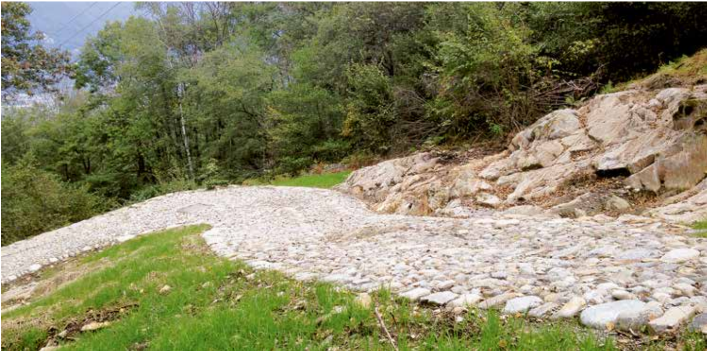
Veduta panoramica della strada ripavimentata
