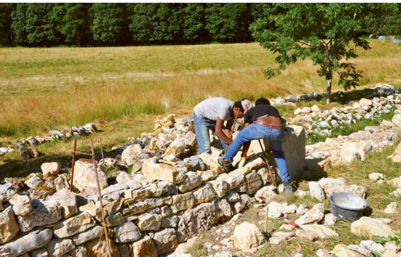
Ouvriers en train de reconstruire un tronçon de mur Lavoratori mentre ricostruiscono un muro Arbeiter beim Restaurieren einer Mauer
