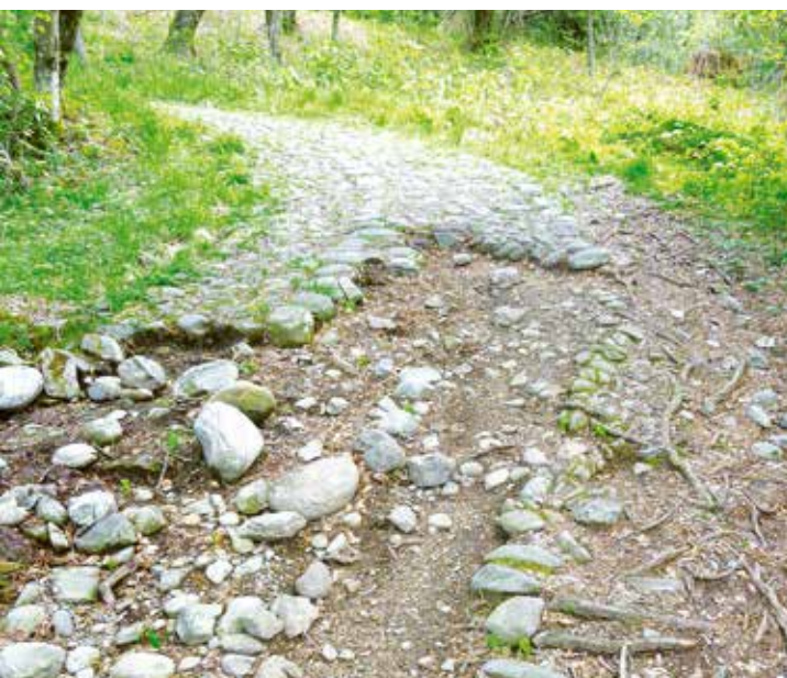
La strada prima dei lavori di ripristino... La voie avant les travaux de restauration... Die Strasse vor den Restaurierungsarbeiten...
