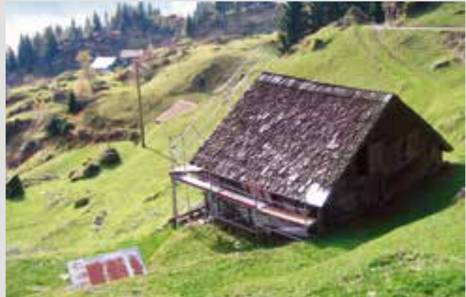
Sanierungsarbeiten in der strukturreichen Kulturlandschaft von Gurtellen UR
