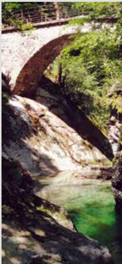
Assainissement d'un pont historique à Monbovon FR
