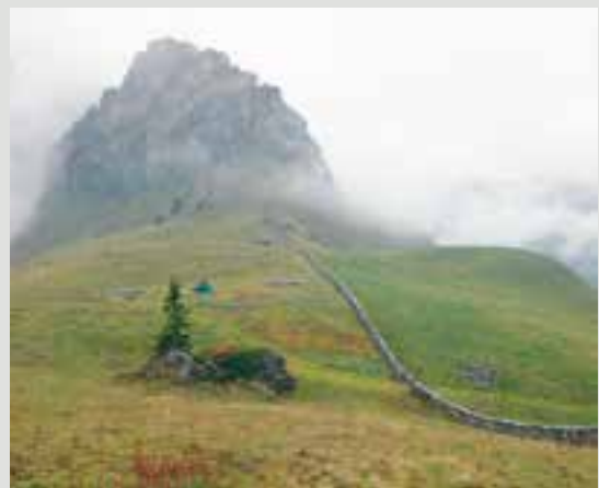
Mur de pierres sèches redressé par des jeunes en camp de vacances à Château-d'Oex VD
