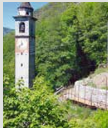
Lavori di costruzione di un muro a secco a Berzona
