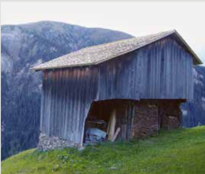
Restauriertes Schindeldach im Safiental
