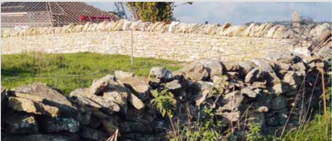
Murs de pierres sèches aux Franches-Montagnes, région soutenue de longue date
