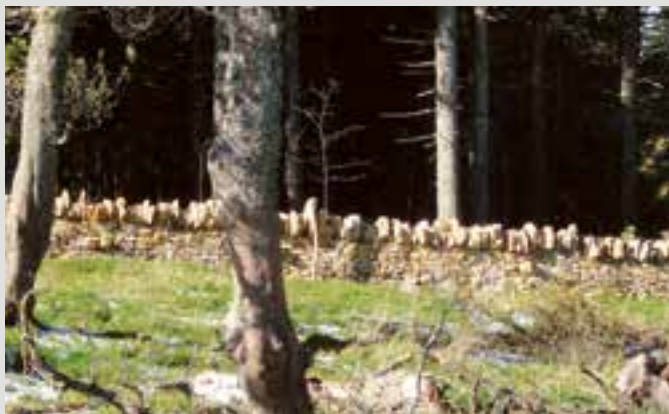
Mur de pierres sèches assaini à La Chaux-de-Fonds
