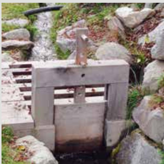
Remise en eau de l'ancien Grand Bisse de St-Jean, Anniviers
