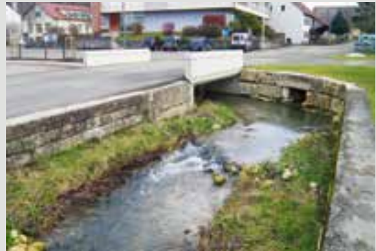
... et après sa revalorisation dans le cadre de la rénovation du village
