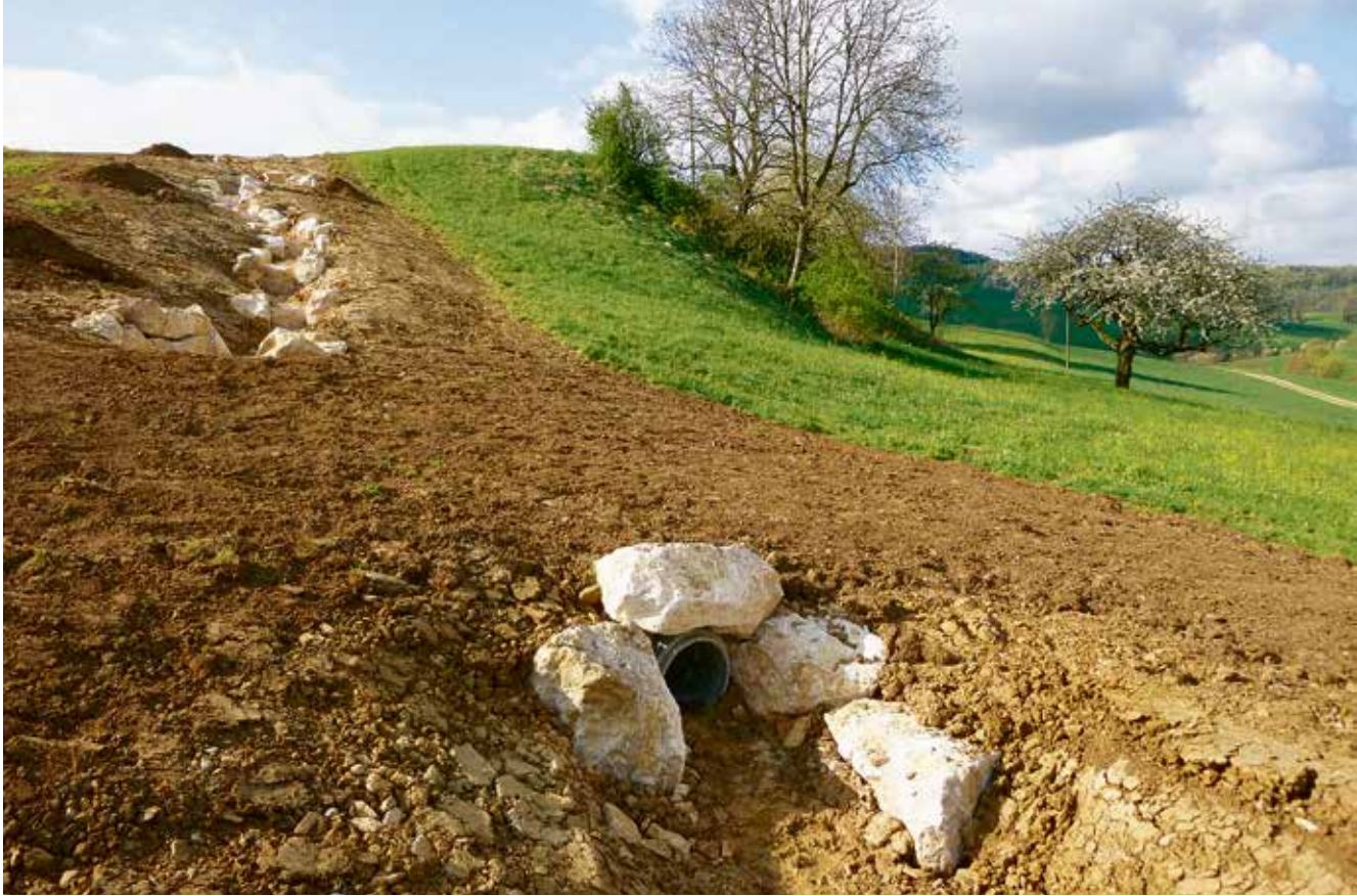
Ausgedoltes Langmattbächlein, unter einem befahrbaren Übergang für die Bewirtschaftung durchgeführt: Langmattbächlein bei Rothenfluh BL Le Langmattbächlein, Rothenfluh BL, coule sous cet aménagement dans le pré pour le passage des machines agricoles. Presso Rothenfluh, nel Canton Basilea Campagna, il ruscello Langmattbächlein scorre sotto un passaggio per il transito dei veicoli agricoli.
