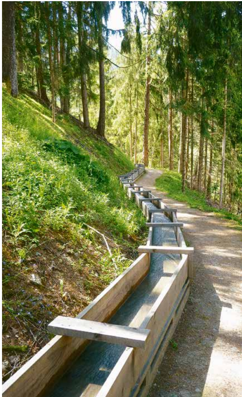
Beispiel für eine erneuerte Suone: Bisse de Ravines, Bruson VS
