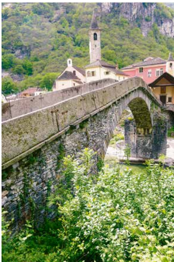
Alte Brücke über die Maggia in Bignasco TI
