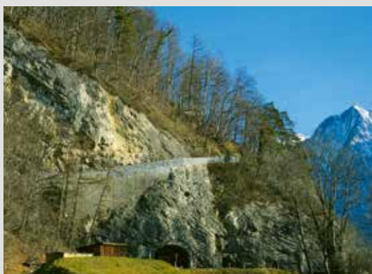
Instandstellung der Alten Schollbergstrasse, Wartau-Sargans
