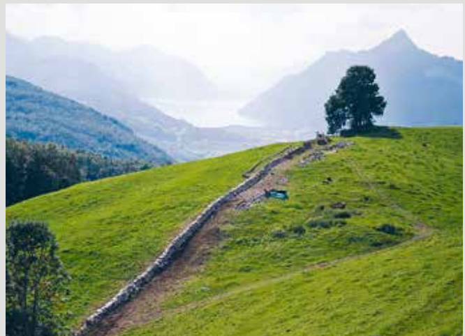
Sanierung Trockenmauer Bürisberg, Schwyz
