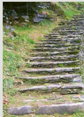
Recupero dell'antica «Via dell'acqua» a Bignasco, Valle Maggia
