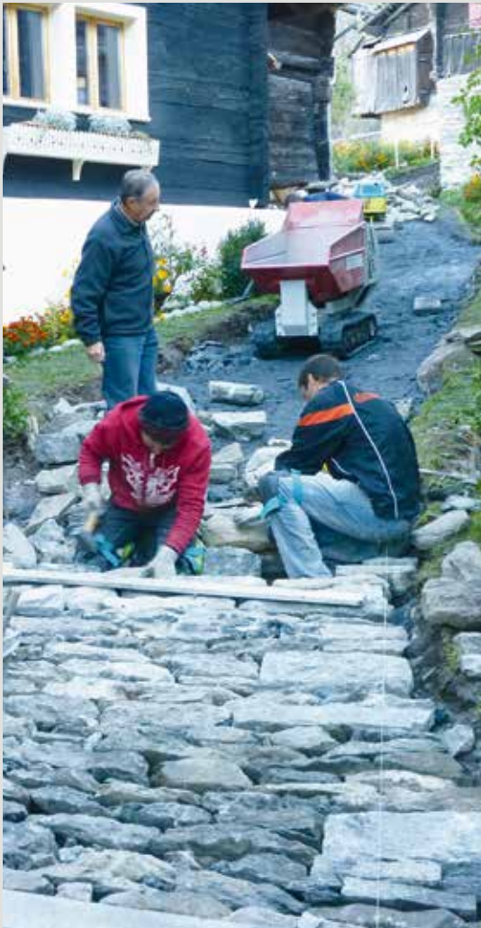
Sanierung der Dorfasse in Eggen
