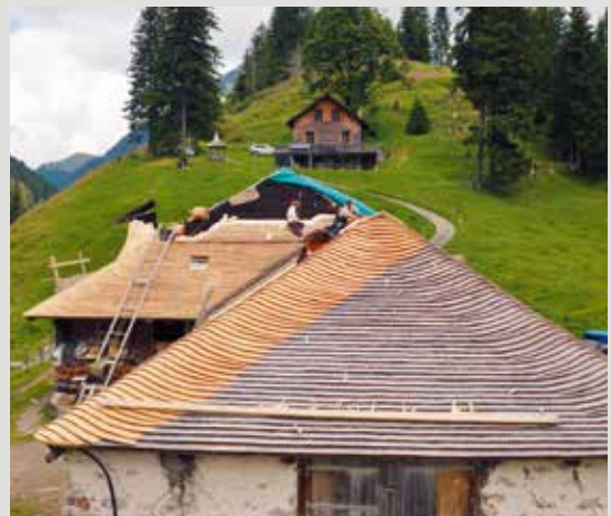
Réfection en tavillons de la toiture d'un chalet d'alpage à Charmey
