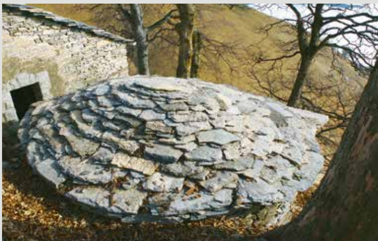
Recupero dell'Alpe Genor - Rifacimento dei tetti in pioda, Valle Muggio
