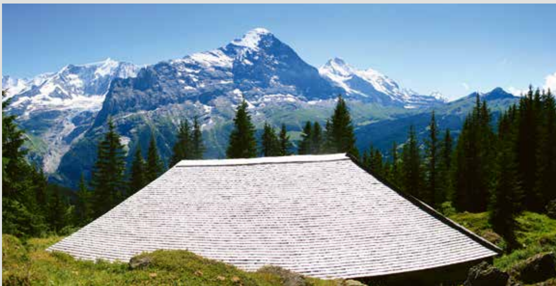
Erneuertes Schindeldach auf der Rinderhütte Suiboden, Spillmatten, Grindelwald
