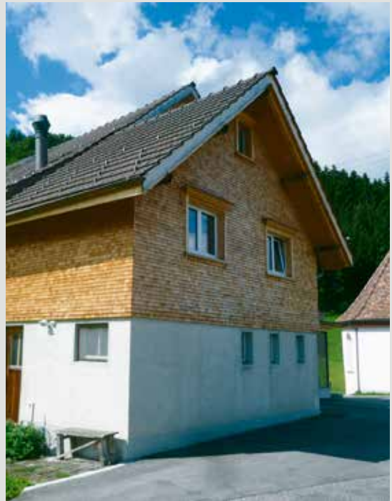
Erneuerter Schindelschirm in Enggenhütten AI
