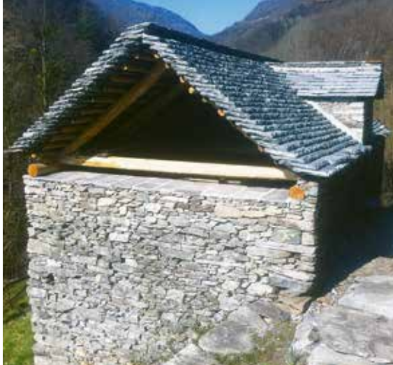
Erneuertes Steinplattendach auf der alten Traubenpresse in Loco/Niva
