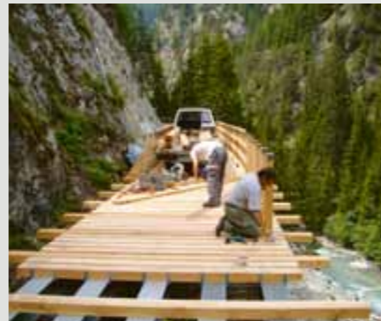
Erneuerte Starlerabrücke, Alte Averserstrasse GR
