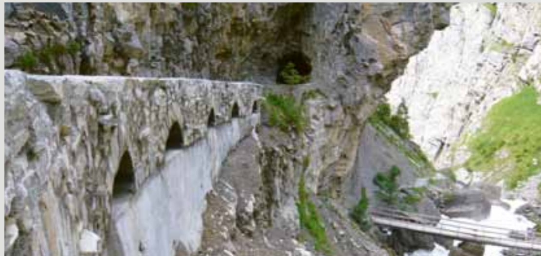
Reparierte Brüstungsmauer am Weg ins Gasterntal BE
