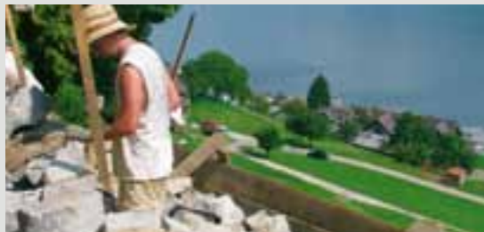
Trockenmauer-Bau in Ennetbürgen NW
