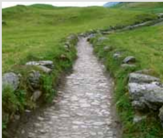
Freigelegter alter Furkaweg bei Hospental UR
