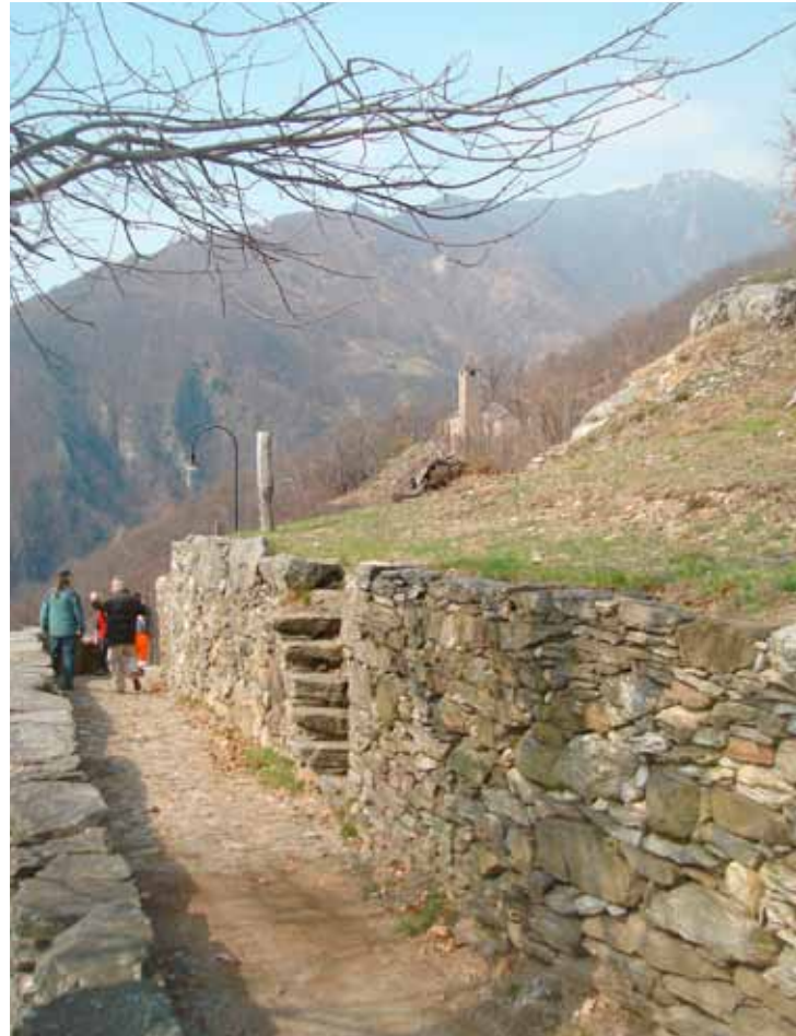
Muri a secco rimessi in sesto lungo il sentiero che porta alla Chiesa di San Bernardo
