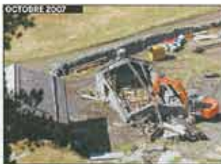
En marge de la reconstruction du chalet d'épave de Chénon, 250 mètres au nord-est, c'est ici le fait de la remise agricole de la Remontiz qui est entièrement démolie.
