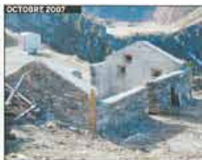
Les travaux vont bon train avec, ici, la consolidation des parois de la remise agricole de la Remontiz avant le pose du massif bois.
