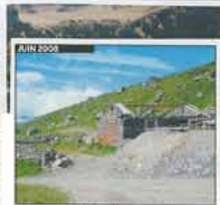
Le point central du futur toit de la remise agricole de la Remontiz est posé, une étape cruciale avant l'installation des chevrons.
