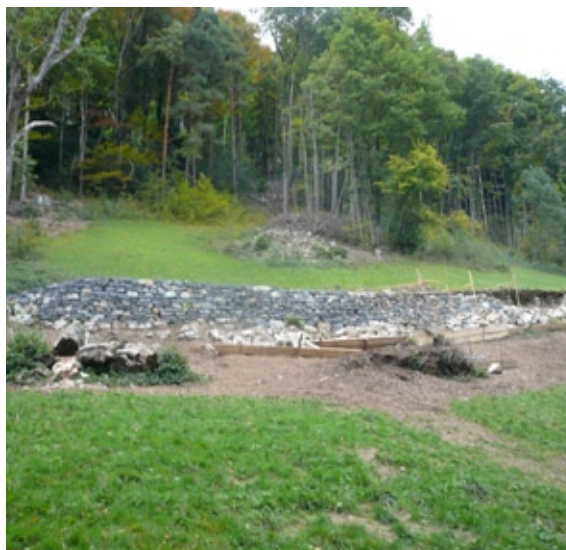
... vom Gebüsch befreit und neu aufgebaut
