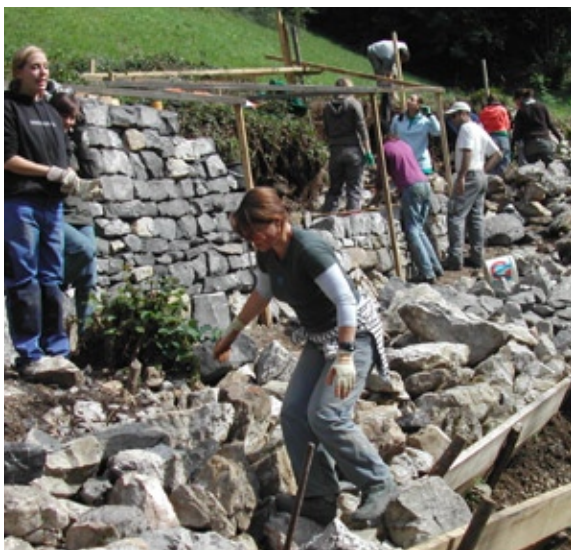
Junge Freiwillige beim Trockenmauerbau
