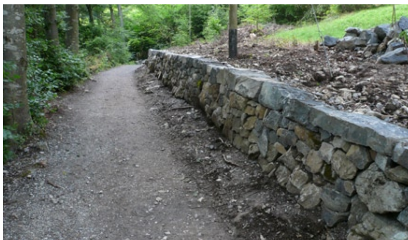
Trockenmauer am Jakobsweg – vor und nach der Sanierung
