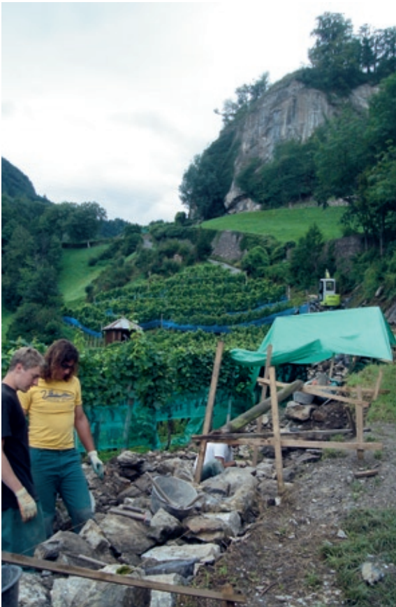
Des personnes astreintes au service civil rénovent des murs de pierres sèches
