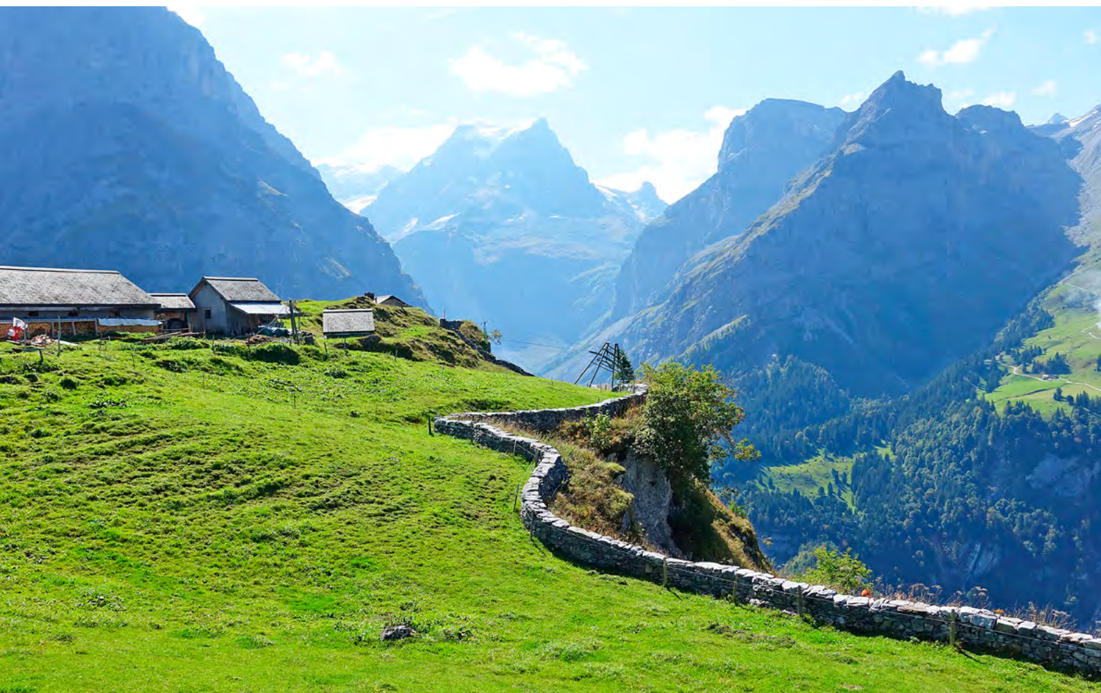
Trockenmauer Baumgartenalp (GL) Unterstaffel
