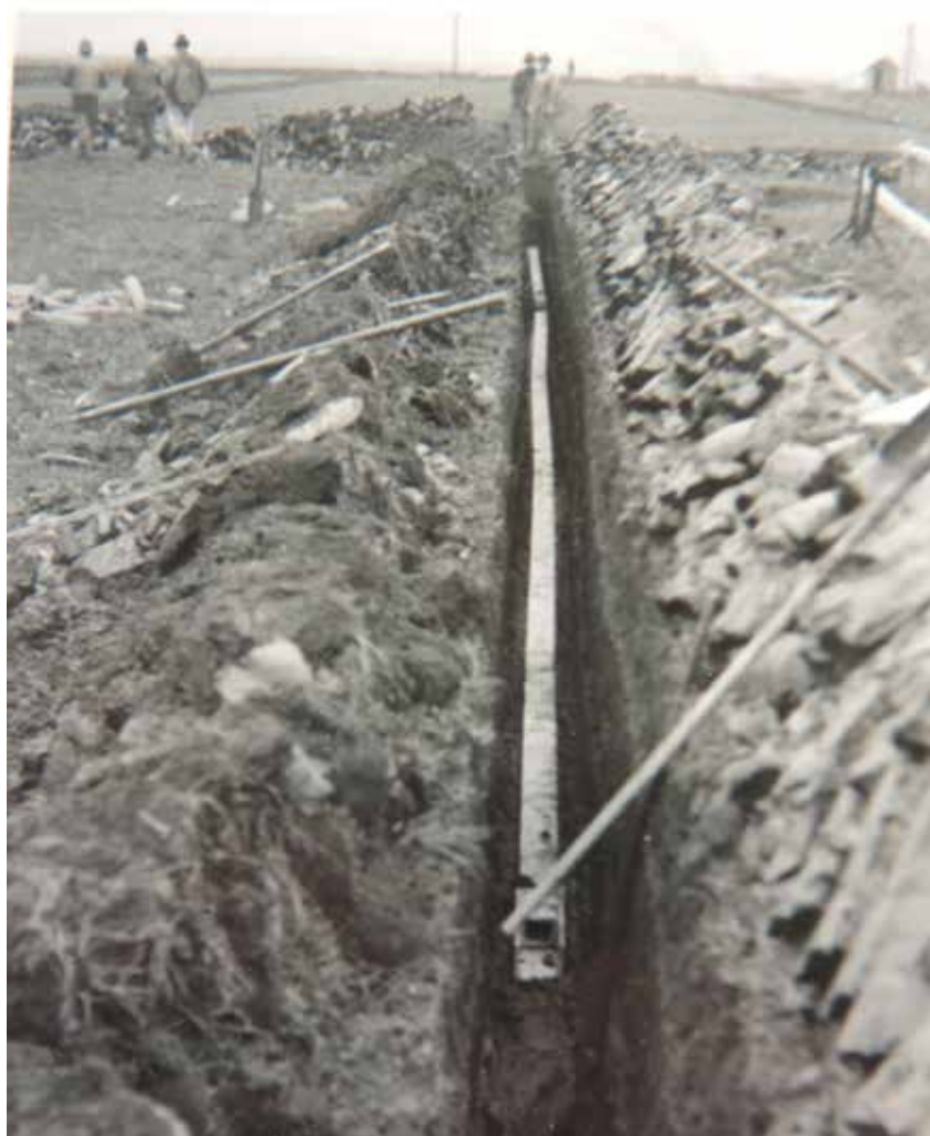
Mit dem Bau von Drainagen wurde das Land entwässert und die Fläche landwirtschaftlich nutzbar gemacht.
